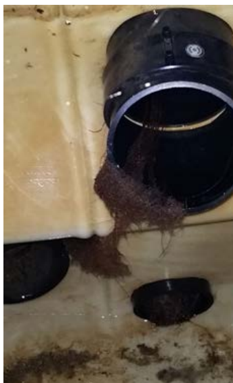
figura 2: Interno della camera di rottura Cad CA 4 : scarico di fondo, partenza tappata, partenza verso il serbatoio AIL (o di Cimo), con radici.
