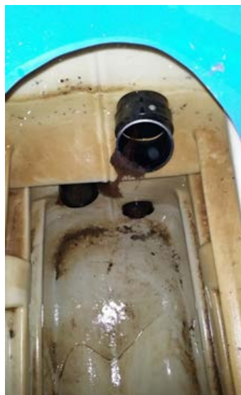
figura 2: Interno della camera di rottura Cad CA 4 : scarico di fondo, partenza tappata, partenza verso il serbatoio AIL (o di Cimo), con radici.
